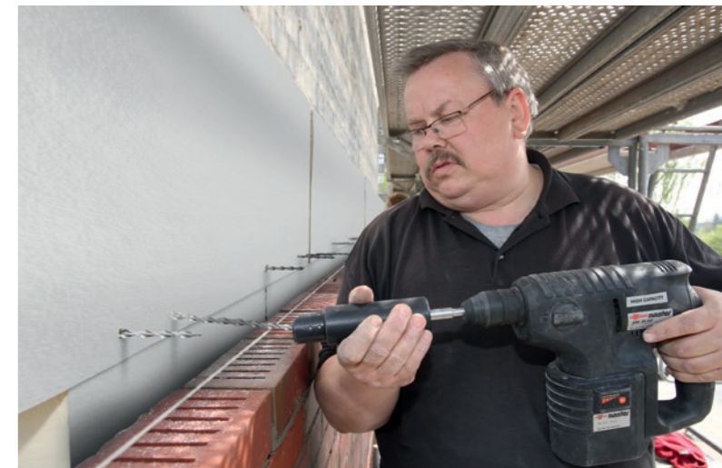
Die Anker werden gleichzeitig mit der Befestigung der PU-Dämmplatten beim Aufmauern der Verblendschale montiert.
