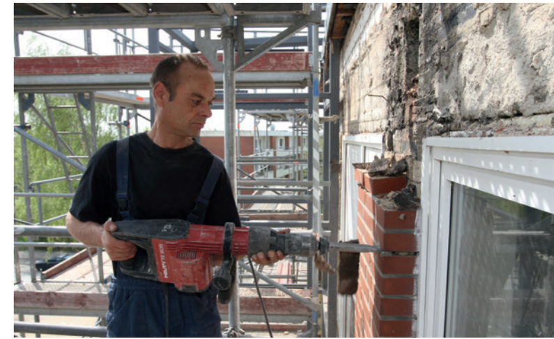
Sanierung einer bestehenden zweischaligen Wand: Abbruch der Vormauerschale.
