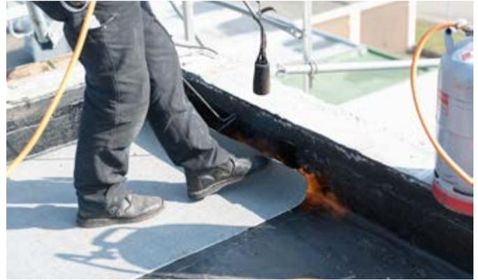
**2.** Da die Anschlusshöhen nicht verändert werden sollten, entscheidet sich der Dachdecker für einen leistungsstarken Dämmstoff mit niedriger Wärmeleitfähigkeit: Polyurethan-Flachdachdämmelement der Wärmeleitfähigkeitsstufe WLS 023, mit einer Dicke 120 mm und einer hohen Druckfestigkeit ( $\geq 100$  kPa).
