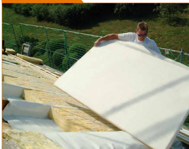
*Polyurethan-Aufsparrendämmelemente können mit anderen Dämmstoffen, die zwischen den Sparren angebracht sind, kombiniert werden. Wird z. B. in einem Altbau die Dacheindeckung erneuert, kann die vorhandene, unzureichende Zwischensparrendämmung erhalten bleiben. Durch die zusätzliche Polyurethan-Aufsparrendämmung wird eine erheblich bessere Dämmleistung ohne Wärmebrücken erzielt.*
